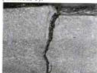
Gambar 7. Struktur makro spesimen Ls-IIC. Retak transversal yang menyebabkan pelat inlet duct terbelah.
